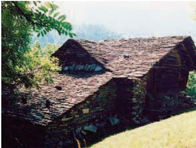
TETTO IN PIODE A DUE FALDE CON ABBAINO TÀCH BET BLÀTTE EN ZWAI AKKE DERMET TÀCHFANTSCHTRU SCHIEFERDACH MIT ZWEI SCHICHTEN UND DACHFENSTER TWO-LAYERED ROOF IN SLATE WITH DORMER
